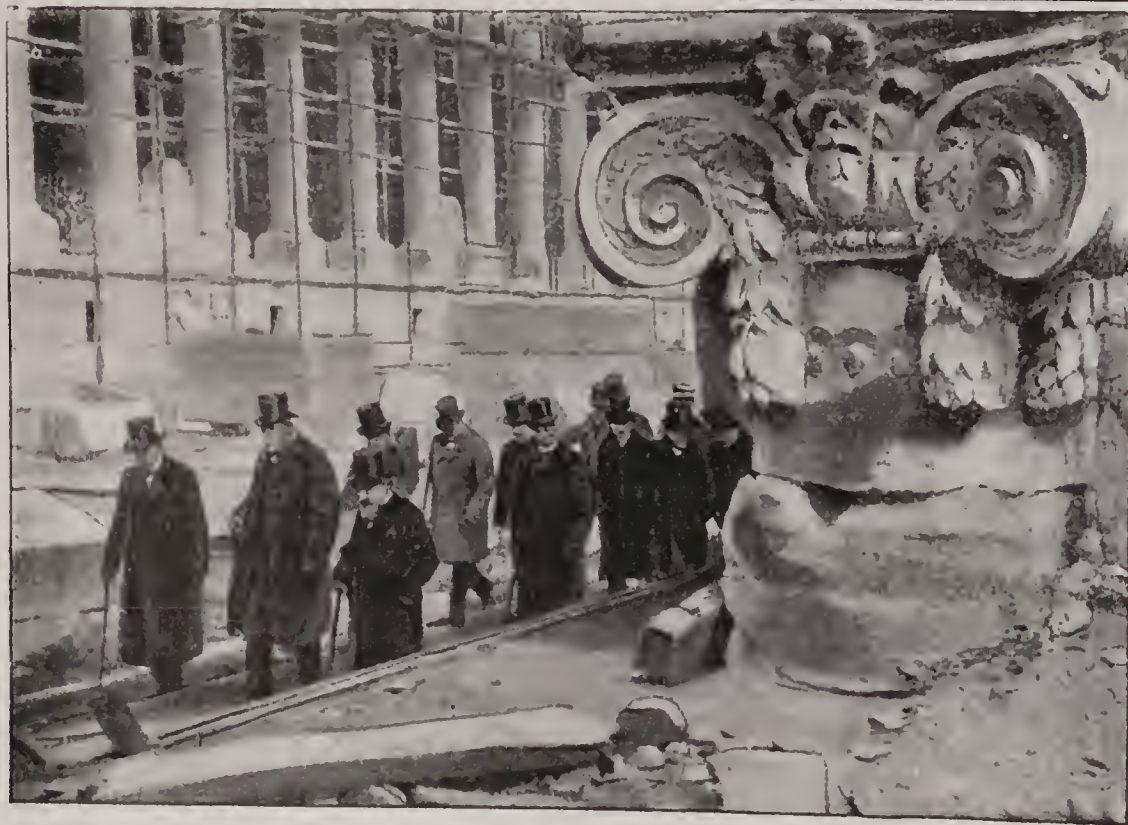
LE ROI OSCAR DE SUÈDE A L'EXPOSITION. Visite des chantiers des Palais des Champs-Élysées.
